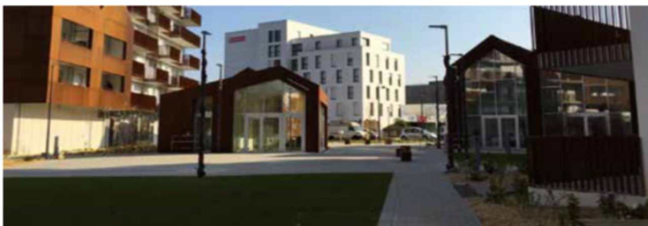
Le Cours des Arts, Rennes (35). Exemple de traitement qualitatif d'un coeur d'îlot. ©DR/Neotoa
