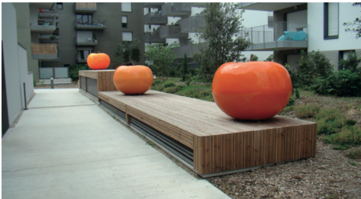
Un traitement soigné des bouches d'aérateur, des parkings souterrains aux Bassins à flot (Bordeaux). ©a'urba
